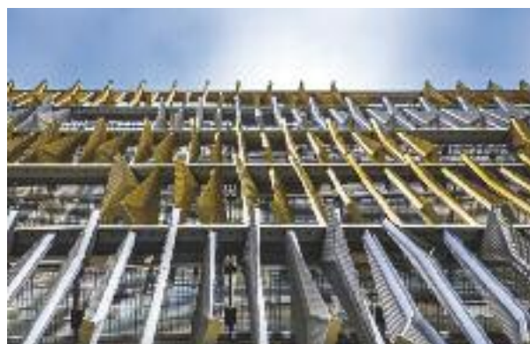
Brise soleil motorisés.
